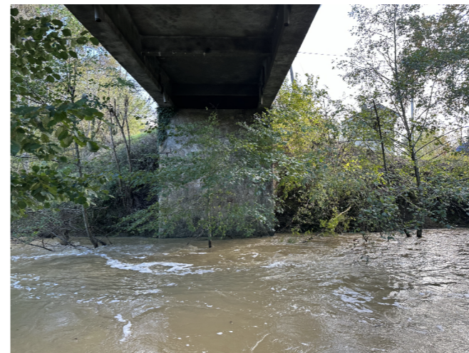
REPRISE PIED CULEE RIVE DROITE
