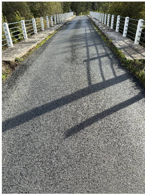
DEMOLITION GARDE-CORS EXISTANT REPRISE ETANCHEITE, JOINTS, VOIRIE et TROTTOIRS
